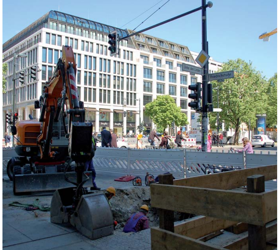
Die bauvorbereitenden Leitungsverlegungen Unter den Linden laufen bereits. © Martin Stefke
